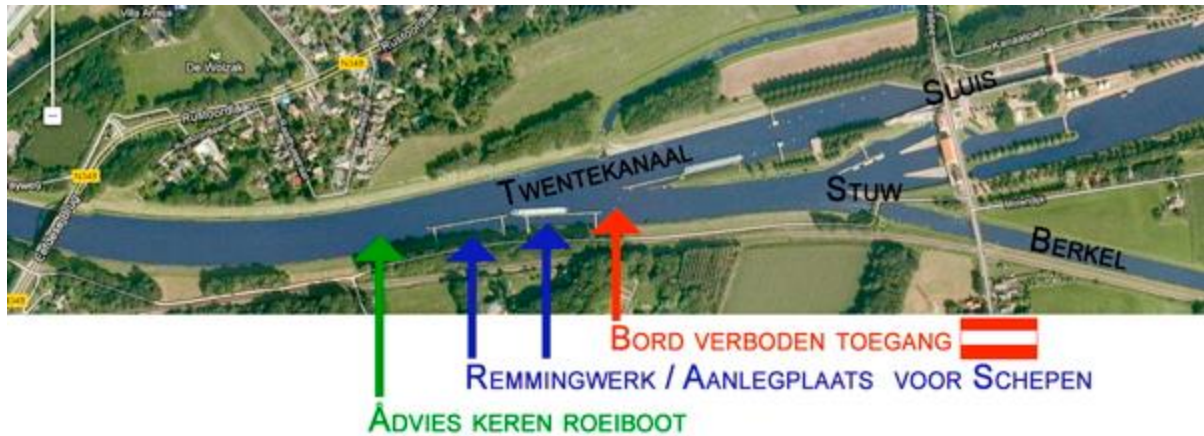
Figuur 14: keer bij het remmingswerk voor de Eefdense Sluis
